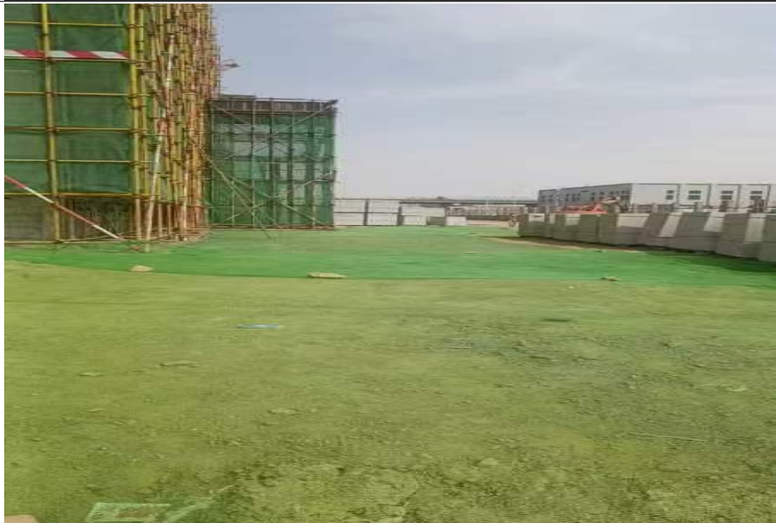
施工场地苫盖
